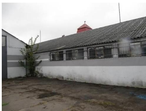
Budynek magazynowy, 10.10.2019 r.
