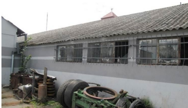
Budynek magazynowy, 26.06.2018 r.
