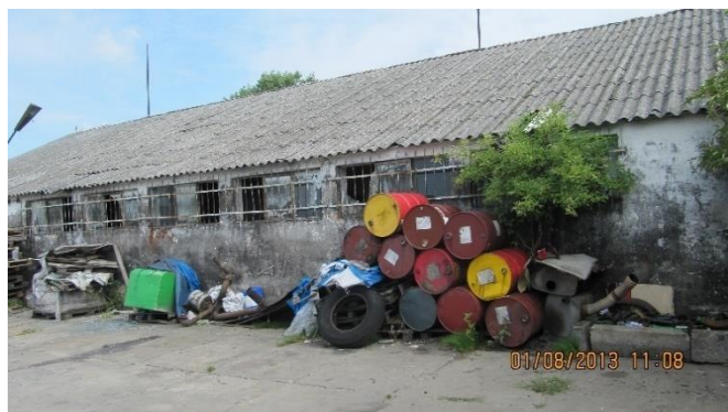
Budynek magazynowy, 01.08.2013 r.
