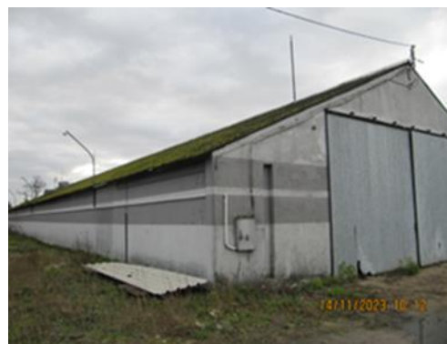
Budynek magazynowy, 14.11.2023 r.
